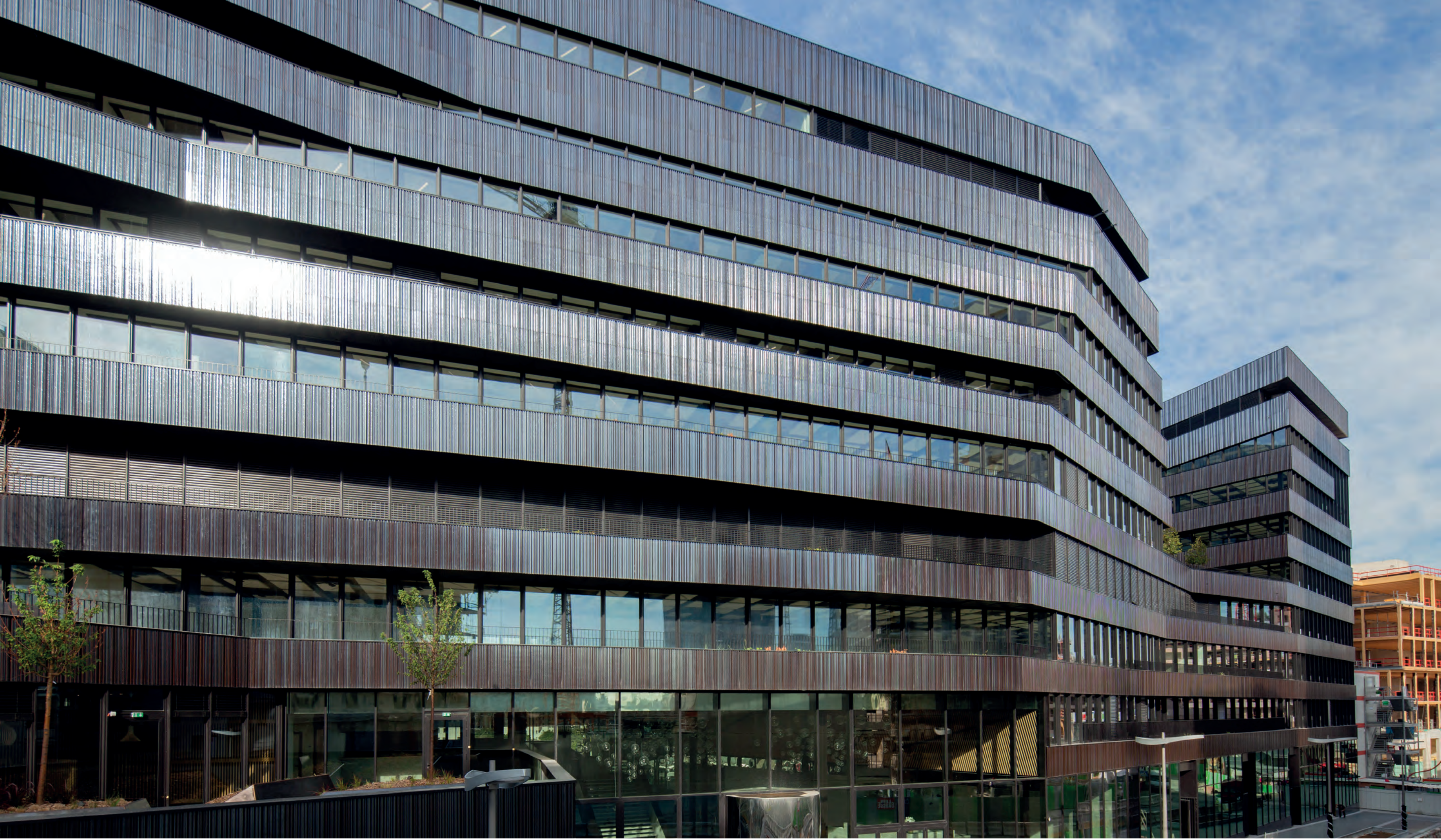
Immeuble Java, Zac Clichy Batignolles.
