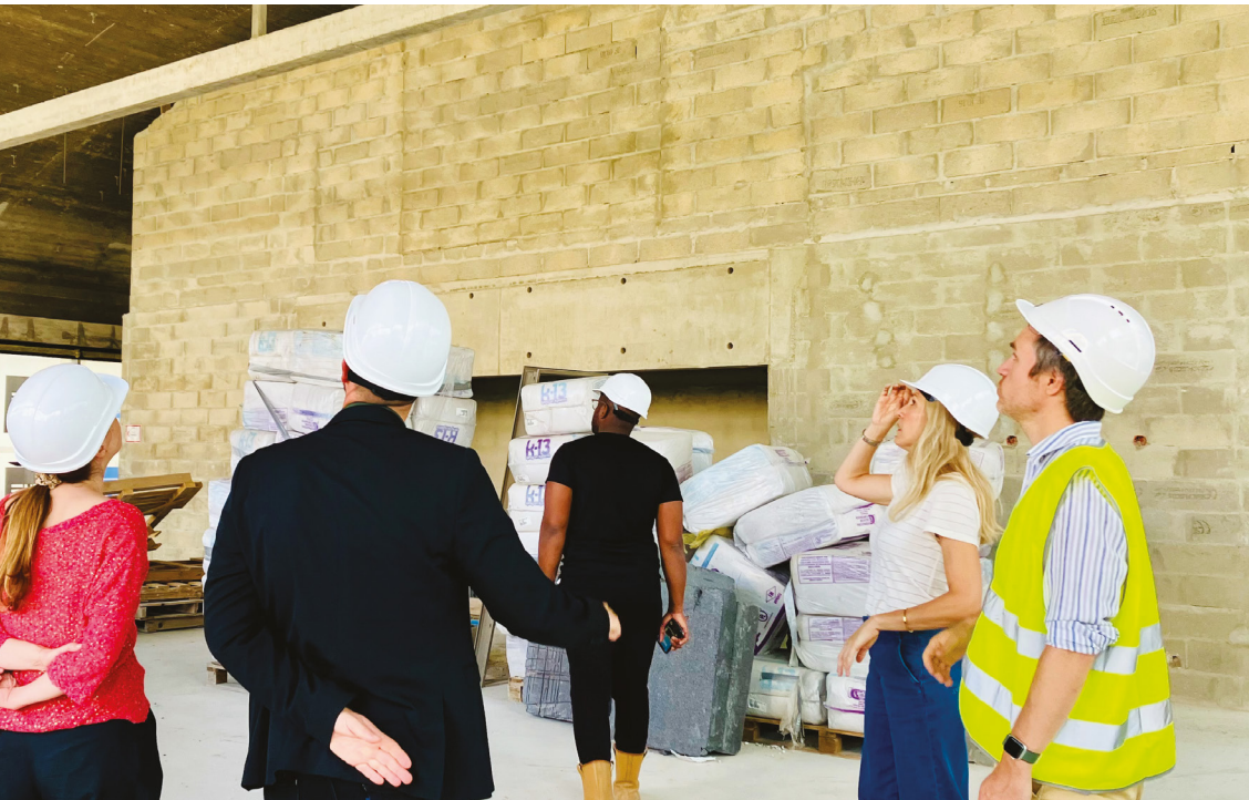
Visite du chantier Acte VII à Ivry-sur-Seine
